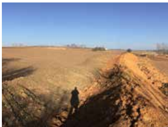
Équipement de l'extension - Ecolys®
