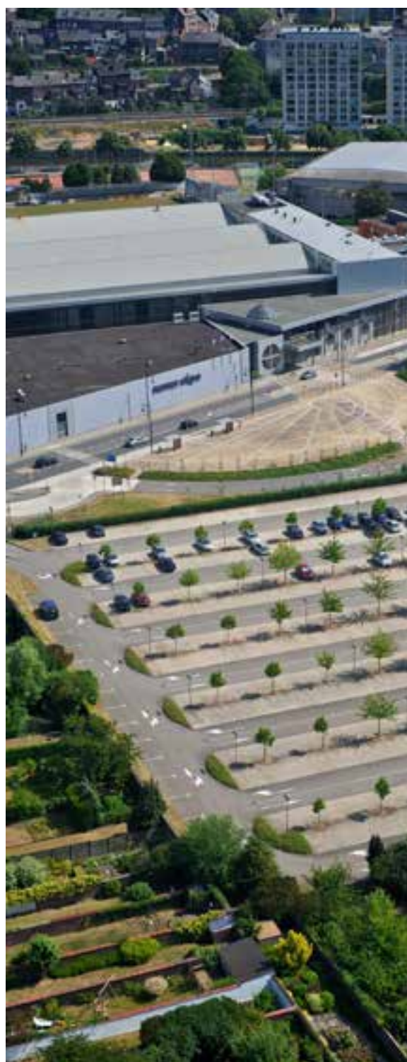
Namur Expo - parking - vue aérienne
