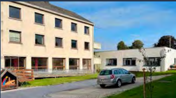
Bièvre - Audit sanitaire de l'ancienne maison de repos
