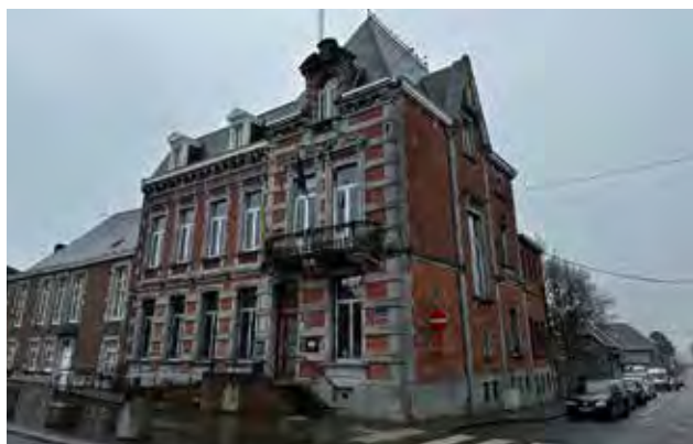
Philippeville – rénovation de la Maison communale
