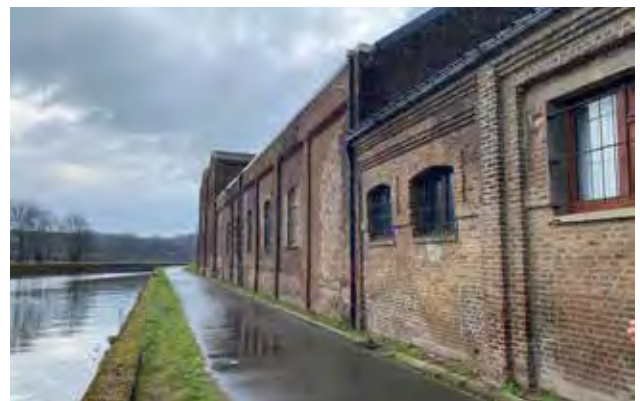
📍 Sambreville – hall des travaux de la Feutrerie
